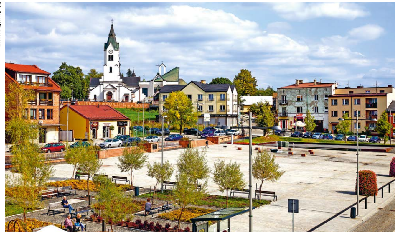
Nowe zagospodarowanie rynku miejskiego w Starachowicach, proj. eM4. Pracownia Architektury. Brataniec.
