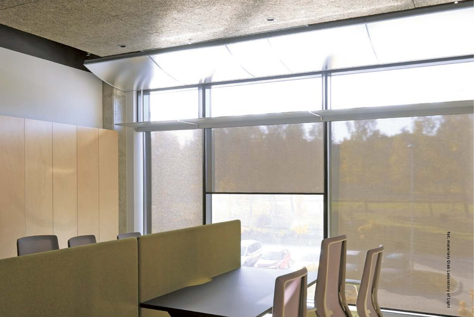
Ustrój okienny wraz z odbłyśnikiem sufitowym. Kierowanie światła dziennego w pomieszczeniu o ciemnym, nieodbijającym suficie. Biurowiec firmy DAKO w Lubartowie.
