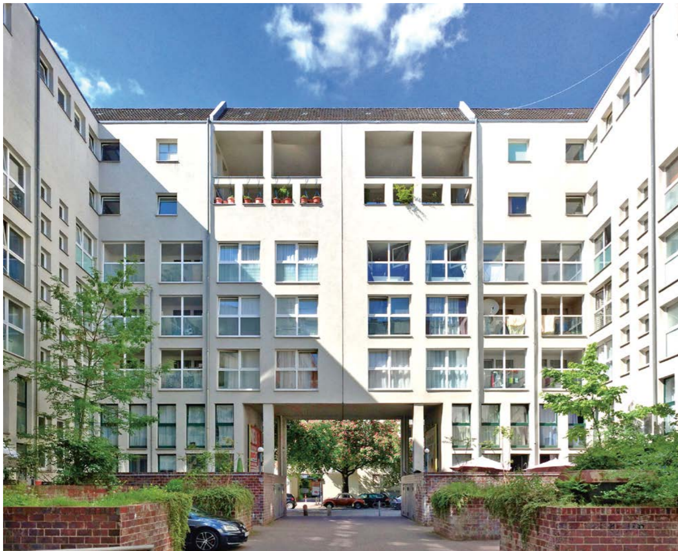
Budynek mieszkalny w Berlinie, proj. Oswald Mathias Ungers.
