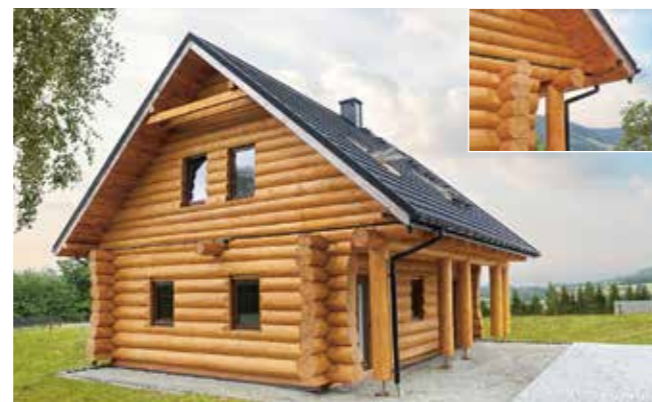
Dom z bali w Głuszycy – połączenie impregnatu i lazury pozwoliło stworzyć wyjątkowo trwałą powłokę odporną na wilgoć, a także na promieniowanie UV i zmienną temperaturę.
