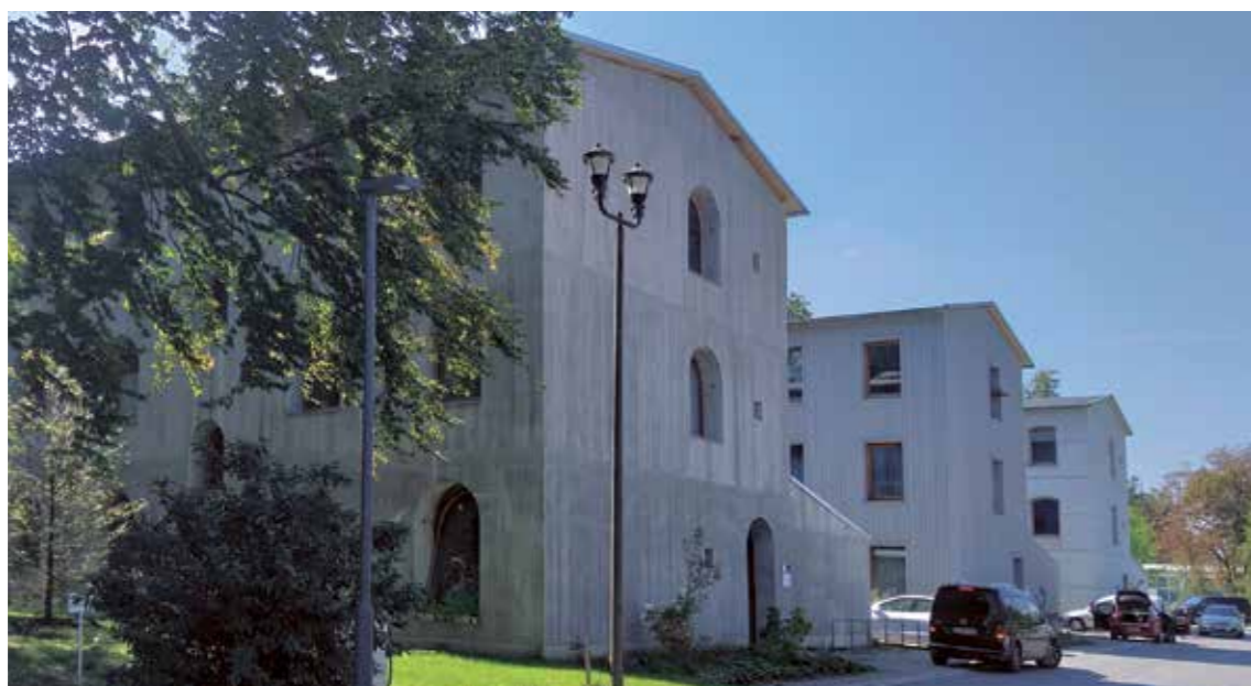
Trzy budynki wzniesione w trzech różnych technologiach (od lewej): ultralekkiego betonu, masywnej drewnianej oraz murowanej z pustaków ceramicznych, proj. zespół naukowy Uniwersytetu Technicznego w Monachium pod kier. Floriana Naglera.
