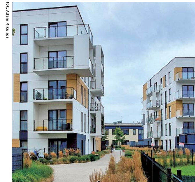
Osiedle mieszkaniowe przy ulicy Jasielskiej w Poznaniu, zrealizowane w 2020 roku w technologii prefabrykowanej przez Pekabex S.A.; proj. Adam Mikulicz Architekci.
