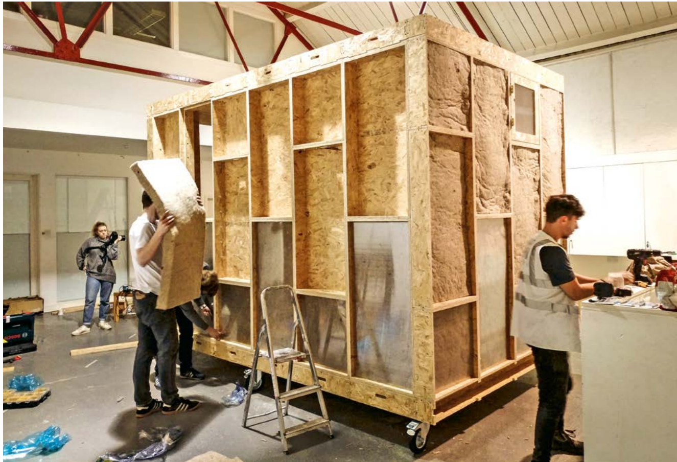
Technologia modularna U-Build. Budynki konstruowane są z bloków o module 300 milimetrów; The Shed Project, proj. Bark Studio.
