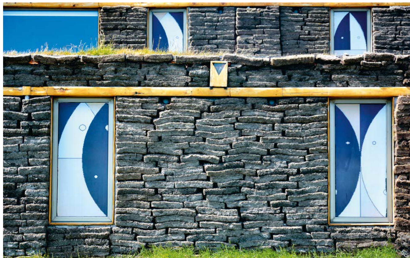
Detal elewacji hotelu Altiplanico.
