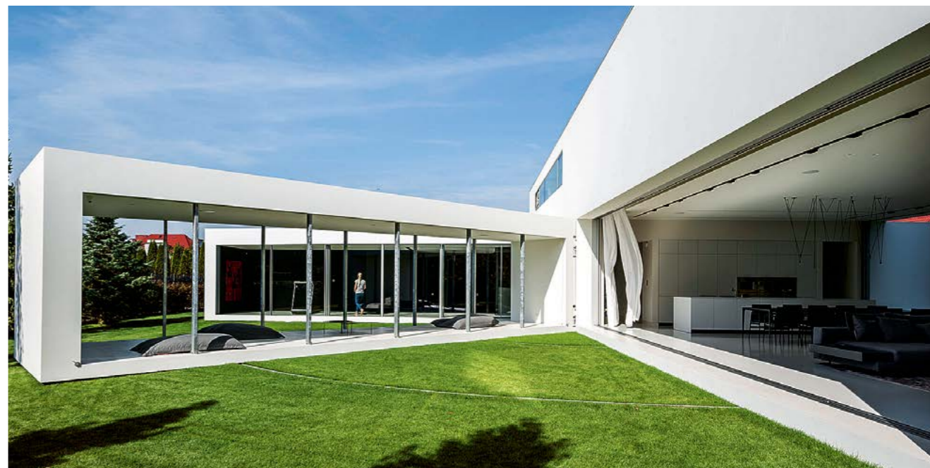
Taras Domu Kwadrantowego podąża za słońcem.
