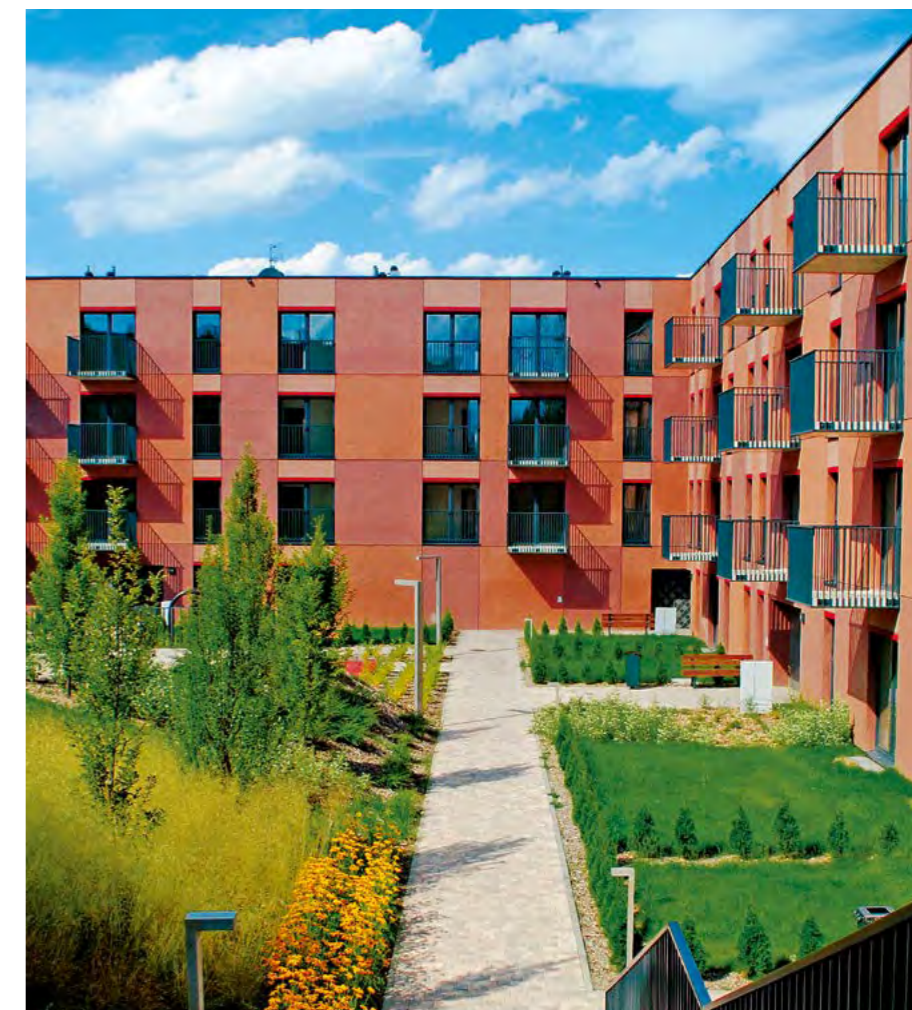
Nowy Nikiszowiec w Katowicach, proj. 22ARCHITEKCI.
