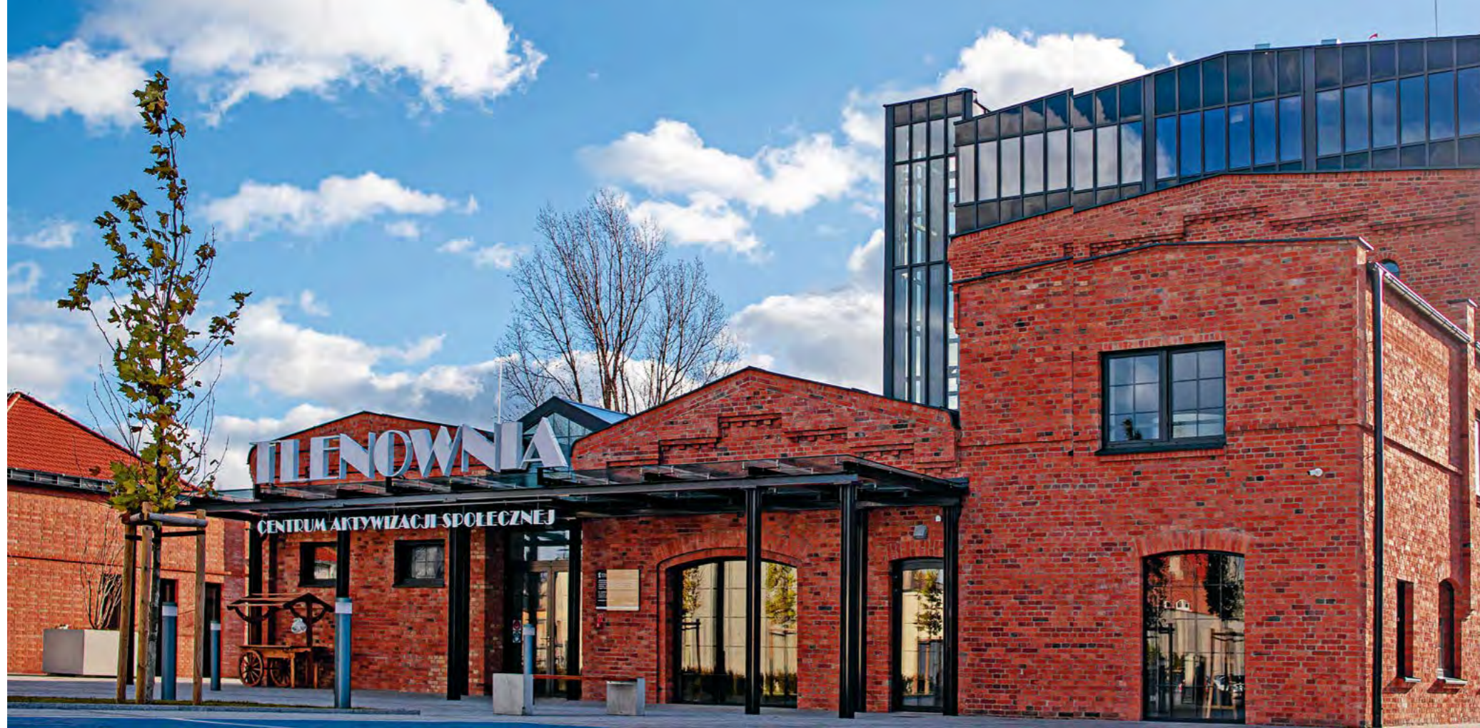
Zrewitalizowana Tlenownia w Czempiniu, zdjęcia sprzed realizacji i po niej, proj. Pracownia Projektowa J.P. Woźny.
