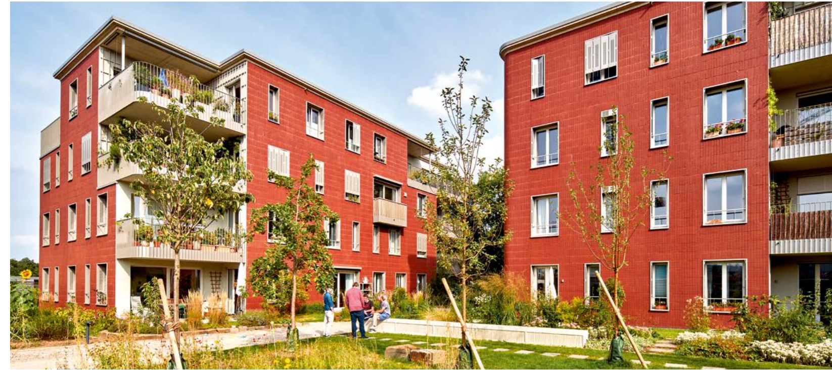
Zespół mieszkalny Energie+ w Kolonii, proj. Zeller Koelme Architekten. Założenie zdobyło III nagrodę KfW Award Bauen 2021, w kategorii Nowy Budynek.
