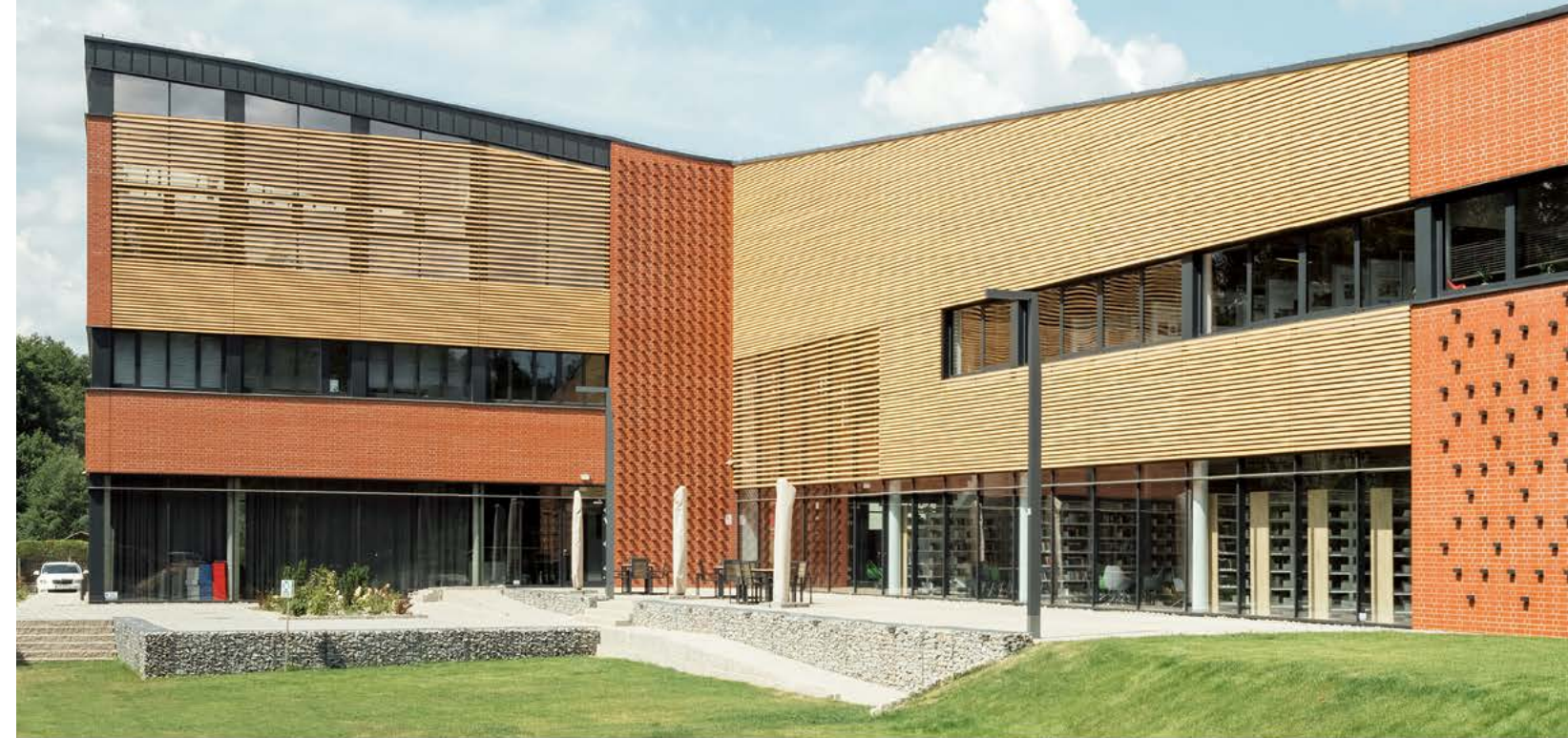
Miejsko - Powiatowa Biblioteka Publiczna im. J. Lompy w Lublińcu - elewacja z cegły klinkierowej Melbourne gładkiej
