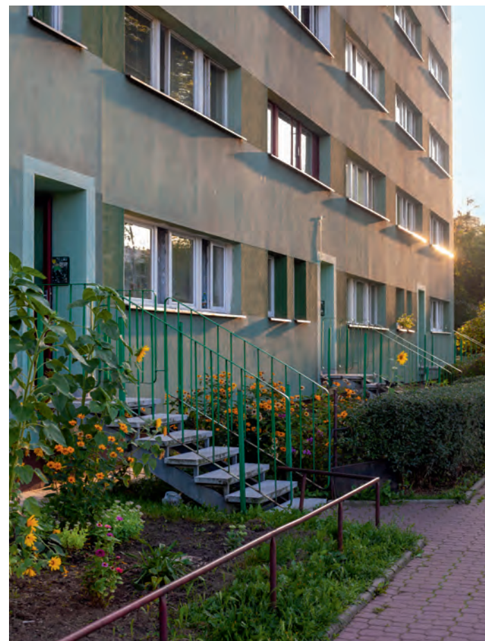
Wejście do klatek jednego z budynków na osiedlu Rakowiec w Warszawie.
