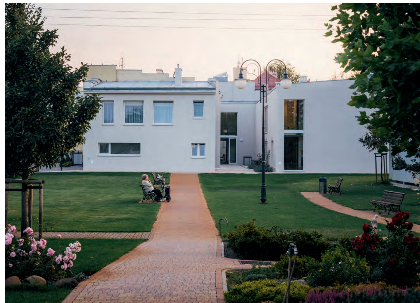
Dom Pomocy Społecznej przy klasztorze Sióstr Franciszkanek Szpitalnych w Dobrzenu Wielkim, proj. PORT.
