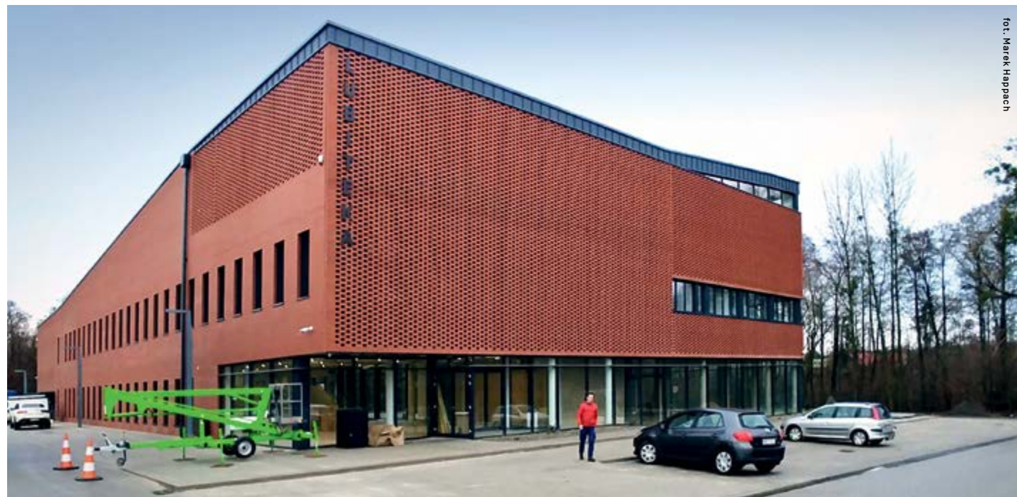
Miejsko-powiatowa biblioteka publiczna w Lublińcu (w trakcie realizacji), proj. H2 architektki.
