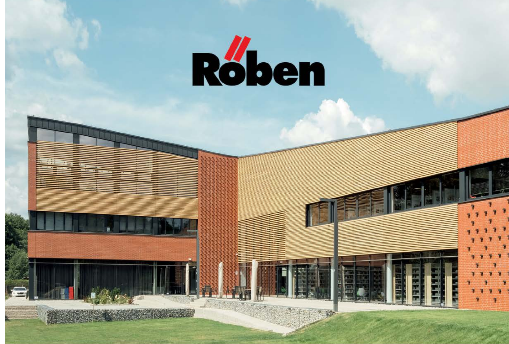
Miejsko - Powiatowa Biblioteka Publiczna im. J. Lompy w Lublińcu - elewacja z cegły klinkierowej Melbourne gładkiej
