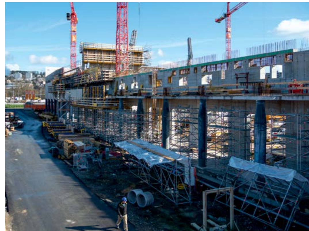
Zabarwione na biało betony architektoniczne zostały wykonane na budowie z zastosowaniem matryc NOEplast.
