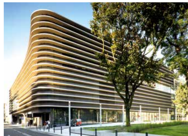
Zdj. 3. Zmodernizowany i rozbudowany Dom Towarowy Renoma we Wrocławiu, proj. Maćków Pracownia Projektowa.
