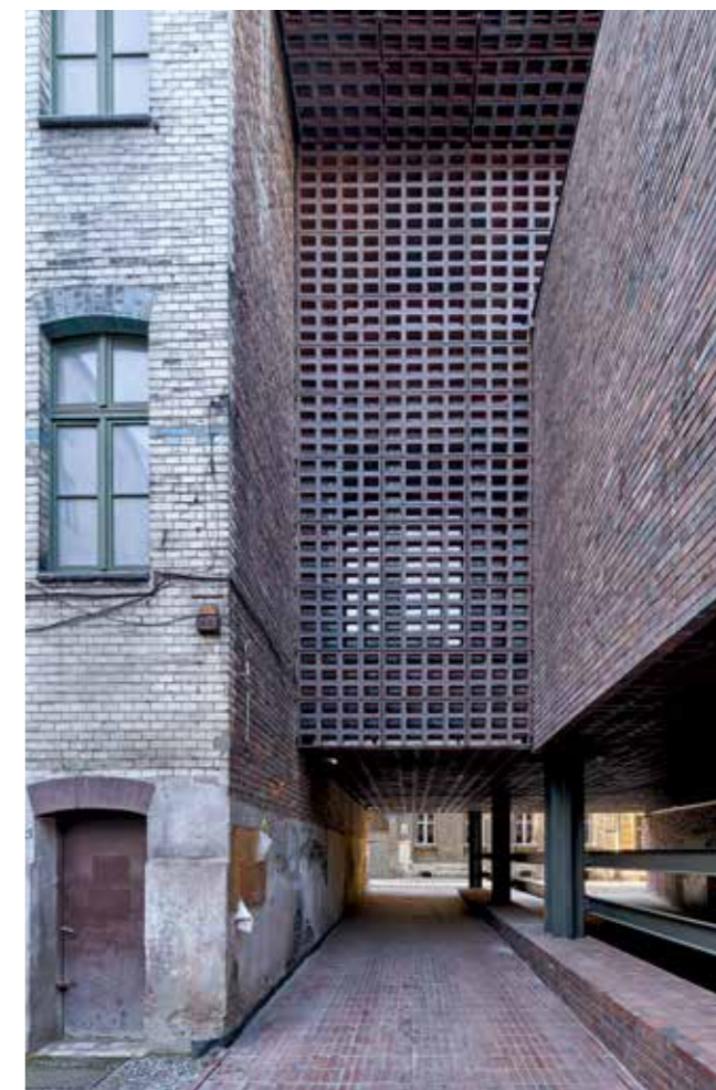
Wydział Radia i Telewizji Uniwersytetu Śląskiego w Katowicach, proj. BAAS, Grupa 5 Architektki, Mateccy Biuro Projektowe.
