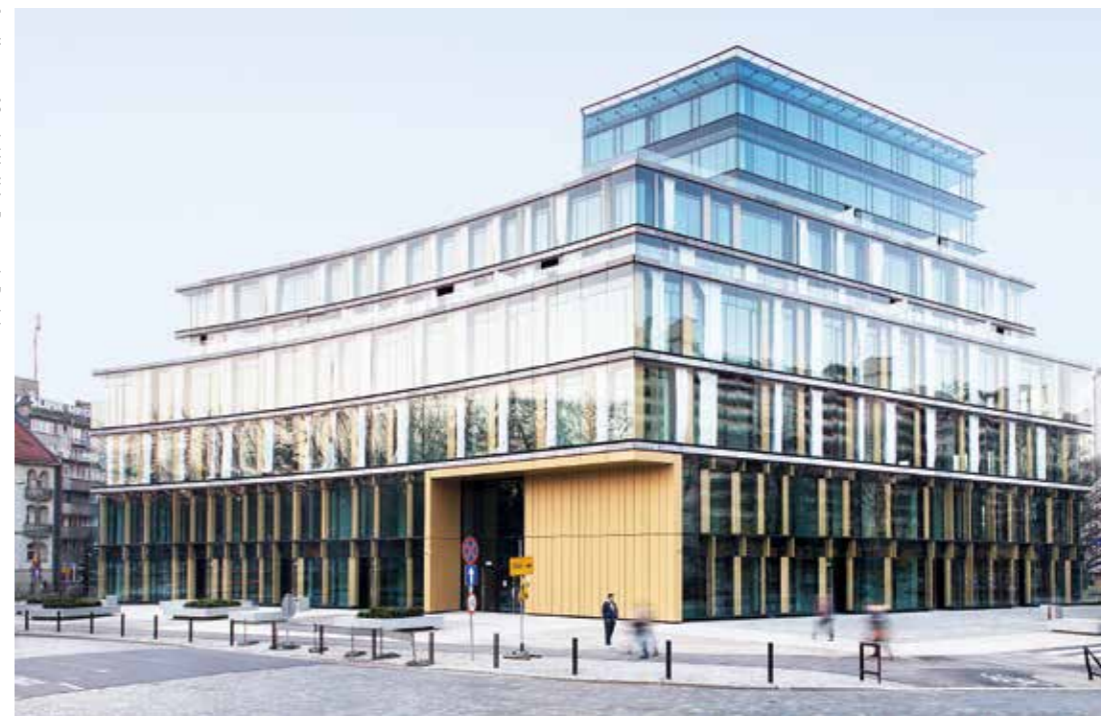
Zdj. 6. Budynek mieszkalno-usługowy Thespan we Wrocławiu, proj. Maćków Pracownia Projektowa.
