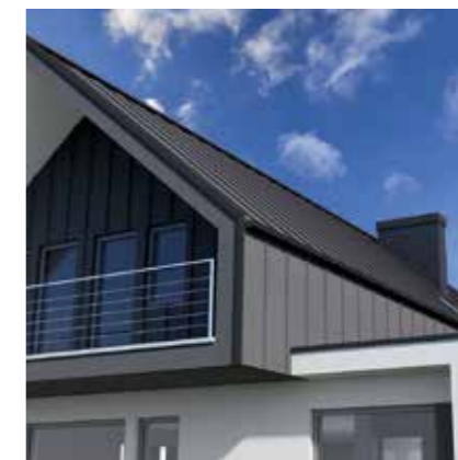
Budynek jednorodzinny: elewacja z użyciem listwy BP19 ozdobnej „na rąbek”.
