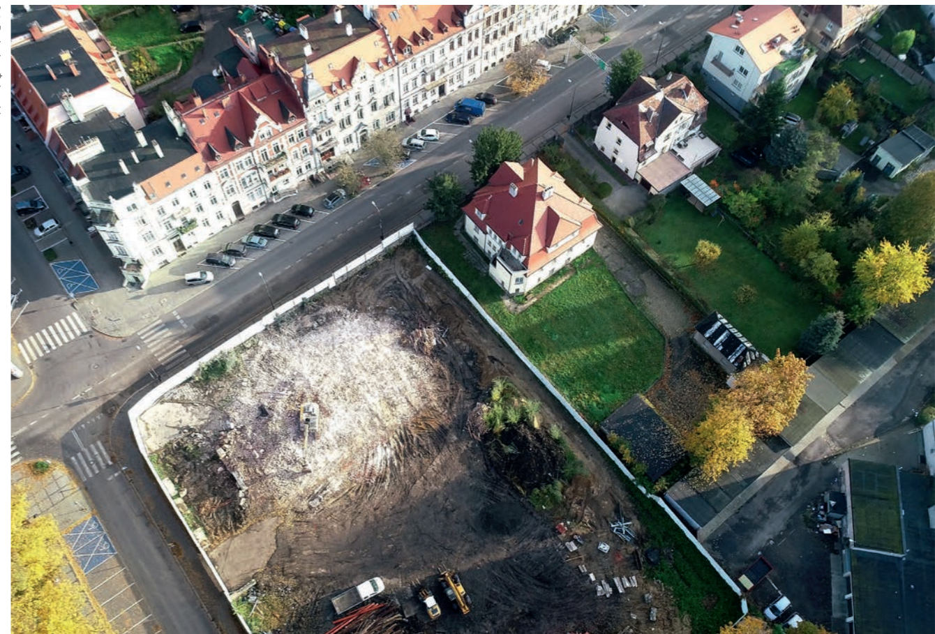
Miejsce po rozebranym budynku dawnego klubu garnizonowego.
