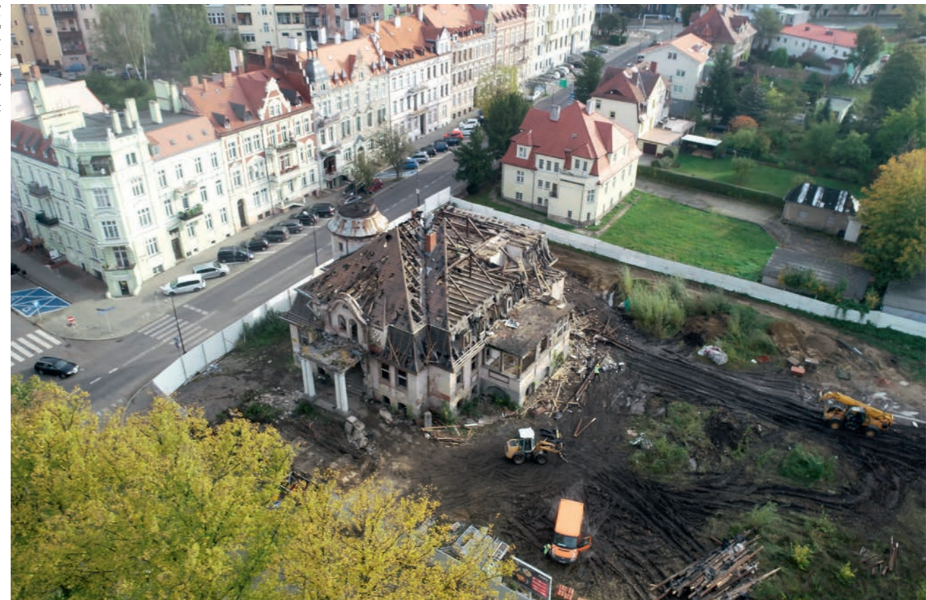
Budynek dawnego klubu garnizonowego w trakcie rozbiórki.
