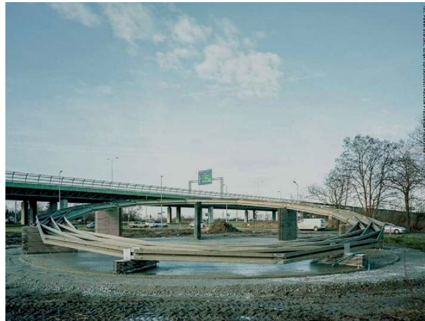
Konstrukcja kaplicy wotywnej we Wrocławiu, wykonana z przydrożnych powypadkowych barier, proj. Maćków Pracownia Projektowa.
