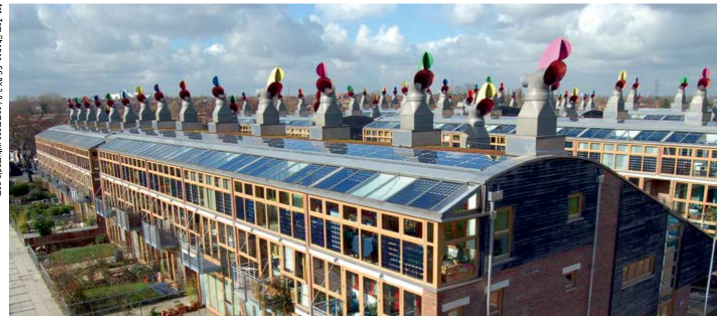
Osiedle BedZED [Beddington Zero Energy Development] w Hackbridge w Londynie, proj. Bill Dunster. Komplex, wybudowany w 2002 roku w Wielkiej Brytanii, uznano za przelomowy do tego stopnia, że został wpisany na listę dziedzictwa (listed building).
