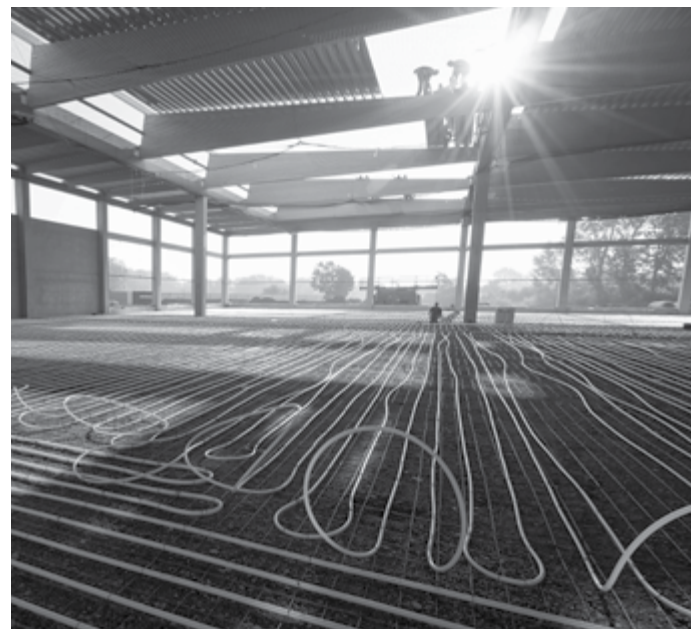
Aktywizacja termiczna betonowych płyt podłogowych.
