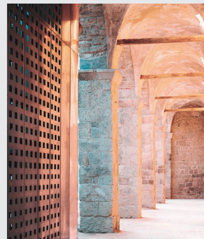
Elementy pokryte perforowaną miedzią w klasztorze Saint-François.
