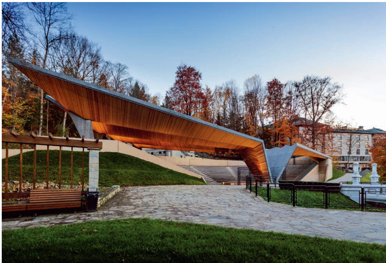
Widok zadaszenia od strony al. Nikifora Krynickiego.
